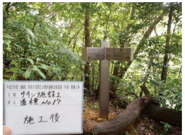
本体：アルミ押出型材 印刷：カッティングシート
