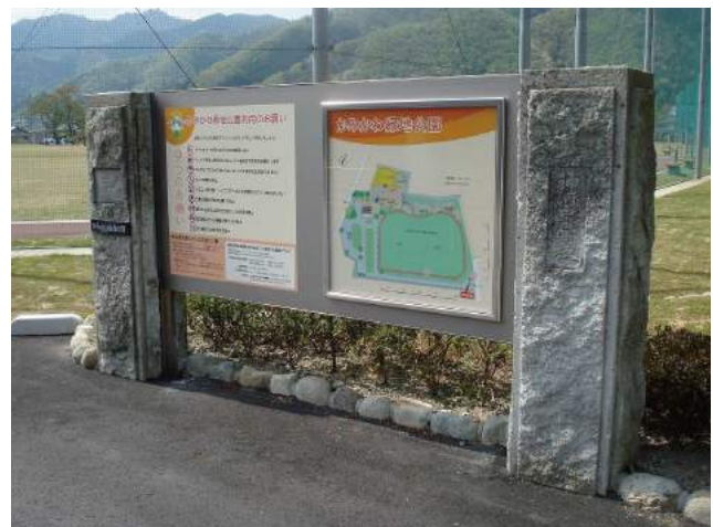
本体：既存石柱+アルミ押出形材 印刷：スーパーカラーR印刷
