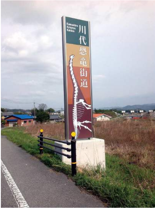
本体：アルミ押出材材 印刷：ハイブリッドカラー印刷
