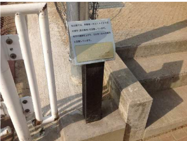
本体：再生プラスチック 印刷：点字+スーパーカラーR印刷
