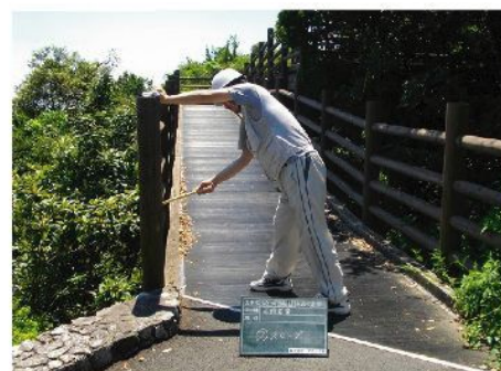
木製スロープ劣化点検 木柱打診状況
