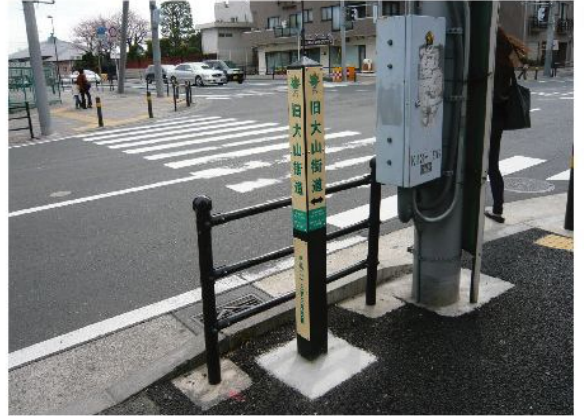
T-061 表示サイズ：w100×h700 表示面：スーパーカラーR 本体仕様：再生プラスチック (緑区長津山旧大山街道 神奈川県横浜市)
