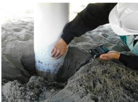
精密点検 遊具支柱 超音波肉厚測定状況
